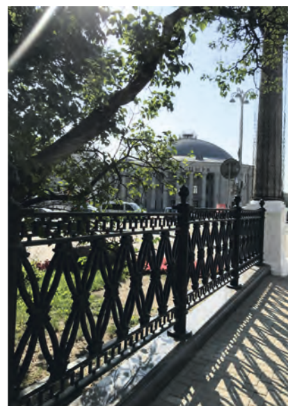
Опоры чугунные и ограждение, выполненные методом высокохудожественного литья, г. Минск, парк им. Я. Купалы
