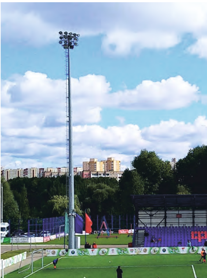
Мачта высотой 25 м с наклонной площадкой, г. Минск, ФК «Минск»
