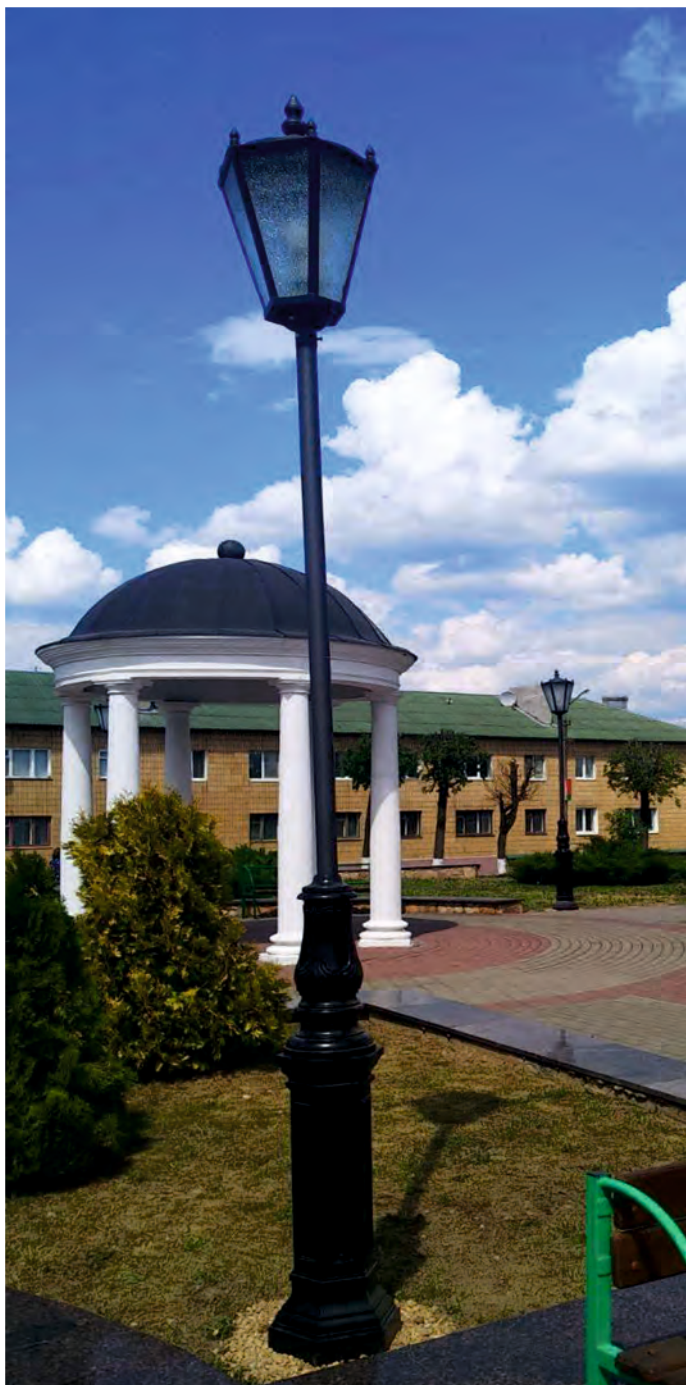
Опора конусная со светильником и тумбой выполненной методом высокохудожественного литья, г.Логойск, Районный дом культуры
