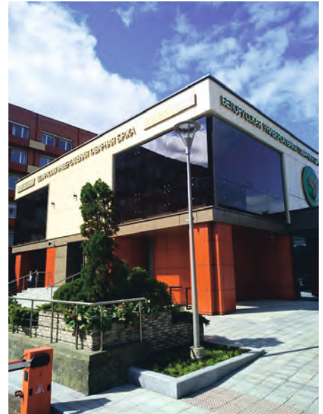
Опора конусная торшерная со светильником, г. Минск, ул. Казинца, 2, Белорусская универсальная товарная биржа
